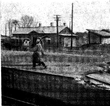
CIUDAD DE CONTRASTES.—Barracones de madera, a poca distancia del centro de la capital, sirven de hogares a los trabajadores moscovitas.
