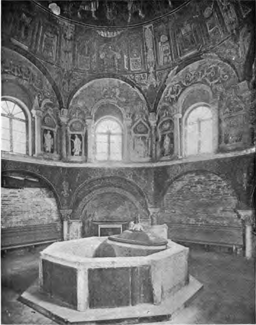
ILL. 46. — Interior, S. Giovanni in Fonte, Ravenna.
